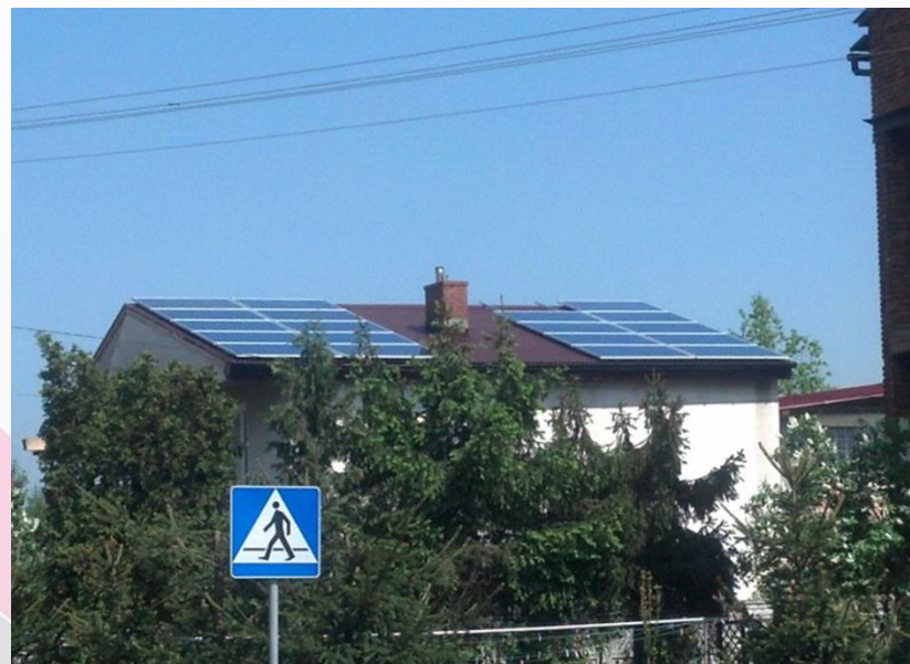
Mikroinstalacja na budynku jednorodzinnym o mocy 4,3 kW
