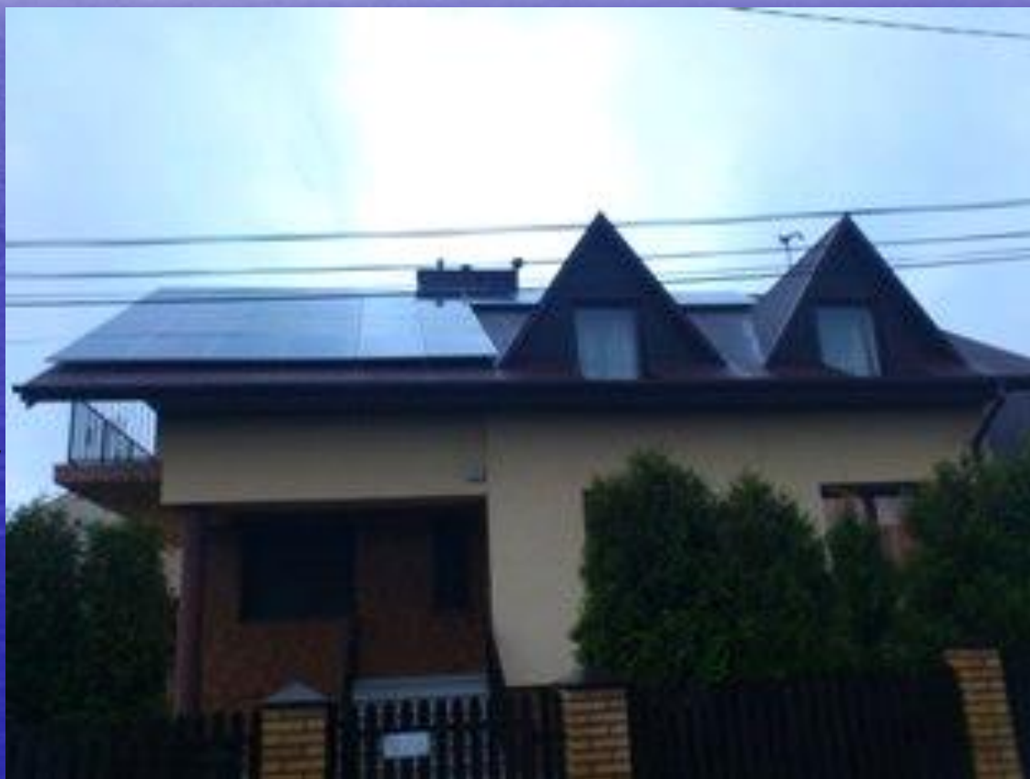
Instalacja off grid
